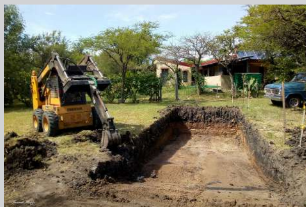
Figura 24 (izq.): excavación manual para un humedal familiar. Figura 25 (der.): Excavación con máquinas para un humedal de mayor tamaño.
