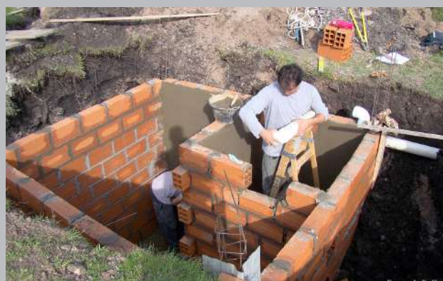
Figura 13a y 13b. Construcción con bloques cerámicos e impermeabilización con revoque de cemento y arena más hidrófugo.
