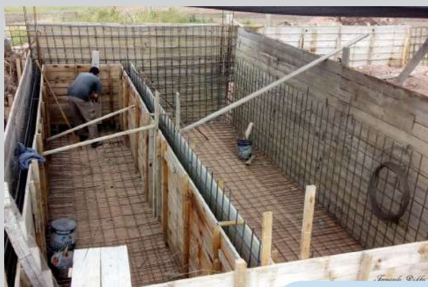
Figuras 14a y 14b. Vista de cámaras dobles de tabiques de hormigón armado construido en obra y bloques de cemento con estructura de hierro, aprovechando los huecos a modo de encofrado perdido
