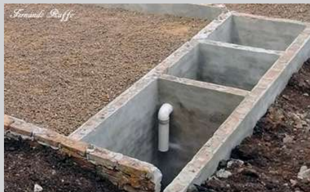
Figuras 12a y 12b. Imágenes de cámara séptica de sección rectangular, con tapa corrida, elaborada en obra.
