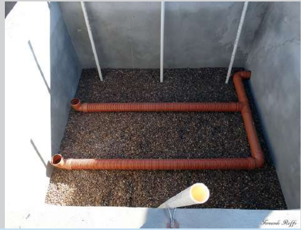
Figura 20 (izq.): vista de la prueba hidráulica de la cañería de ingreso, luego se recubre con 10 cm de piedras. Figura 21 (der.): vista de la cañería de captación en donde falta conectar los caños de los respiraderos para que trabajen a presión atmosférica evitando sellos hidráulicos de aire que dificultan el vaciado del humedal.
