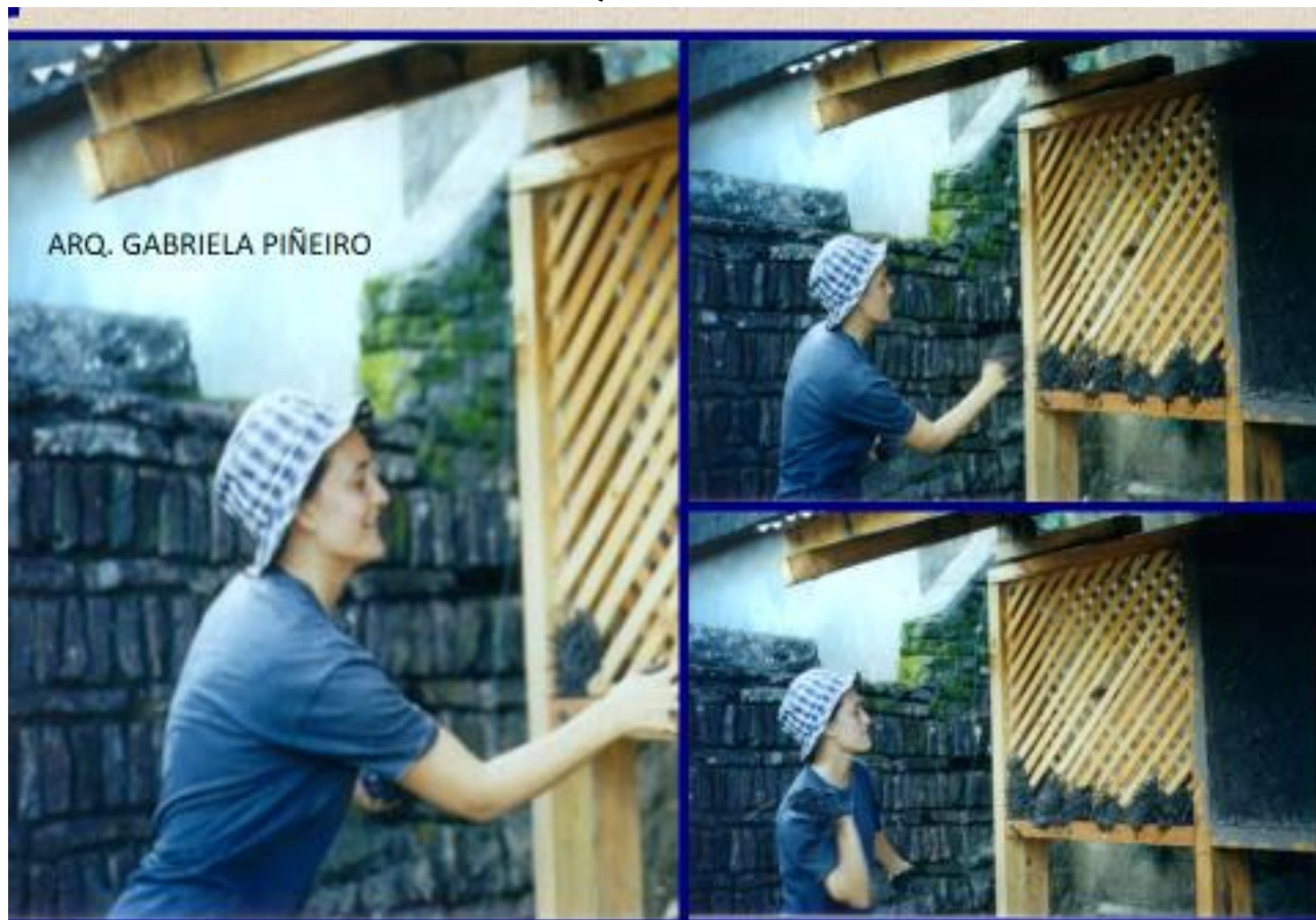
PRODUCCION DE PANELES DE FAJINA – ESTRUCTURA – ENTRAMADO – RELLENO TIERRA PAJA – REVOQUES DE ARCILLA Y CAL
