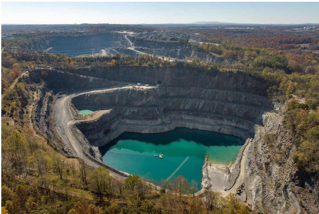
Figura 3. Milestone Reservoir, Virginia (Estados Unidos). Conversión en curso de una cantera en reservorio de agua cruda para reforzar la resiliencia ante sequía o contaminación del río Potomac. Fuente: Clark Construction, imagen oficial del proyecto.
